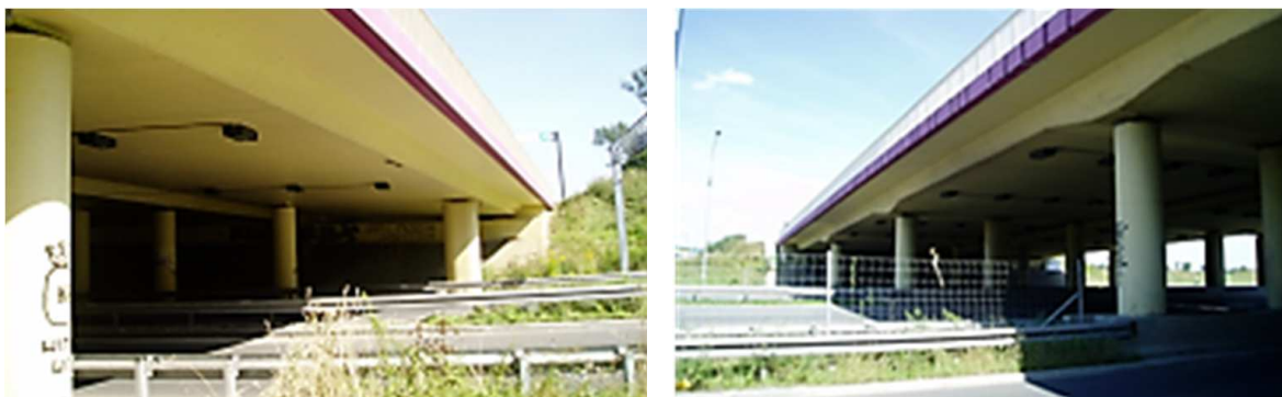
Rys. 4. Wiadukty o ustroju ciągłym
