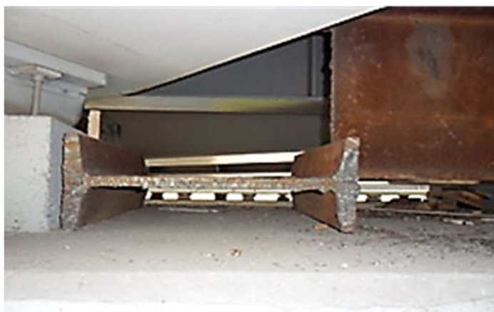
Rys. 9. Tymczasowa konstrukcja oporowa
